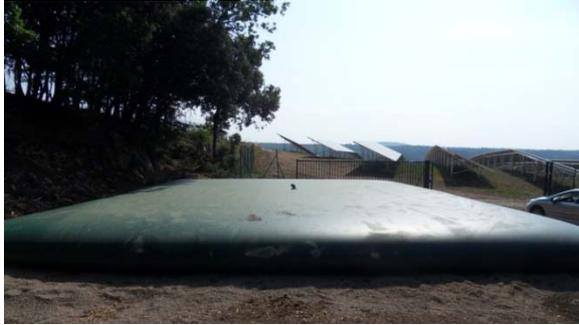
A l'intérieur de l'enceinte et au niveau de l'accès une citerne incendie souple de 120 m<sup>3</sup> sera accessible directement depuis l'extérieur de la centrale pour faciliter les interventions en cas d'incendie. Les dimensions moyennes sont en base 12 x 9 m pour une hauteur de 1,50 m.
