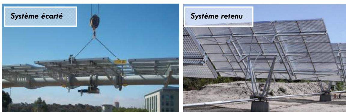
C'est le système CPV le plus léger en termes de dimension qui a été retenu (4,5 m). Avec des structures de dimensions plus acceptables il s'intégrera mieux dans l'environnement du site et nécessitera moins de travaux pour la mise en œuvre ainsi que la maintenance.
