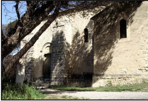
Vue de l'église au Sud
