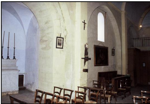
La Nef : Côté Sud
